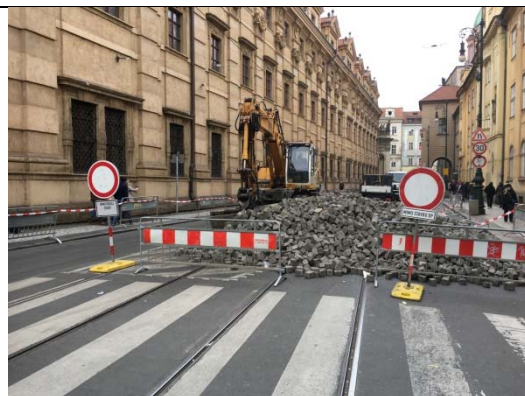
Obrázek 2: Stavební práce v Křižovnické ulici
